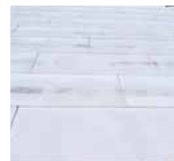
Schnutí antikoroziního nátěru cca 4–5 hodin
