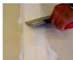
Vtlačte pásku do tmelu, nechte schnout cca 4 hod. při 20 °C
