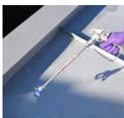
Nastříkejte vysokotlakým stříkacím zařízením (2 vrstvy)
