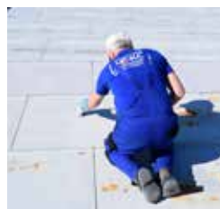
Ošetřená plocha po aplikaci antikoroziního nátěru
