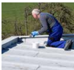
Korozi napadená místa opatřete nátěrem antikoroziní barvy
